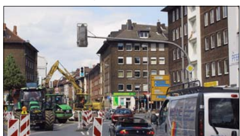
Achtung, Staugefahr: Mitten im Albersloher Weg in Münster liegt die Baustelle für ein neues Schachtbauwerk. Bis Mitte Juni geht es in Richtung Hansaring nur einspurig daran vorbei. Bild: Zinke
